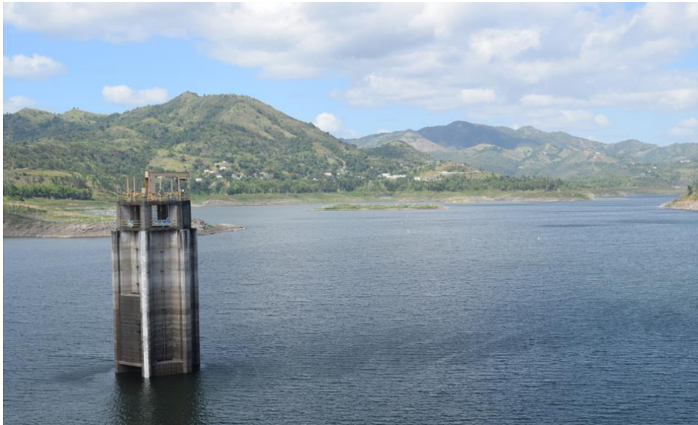
Figura 3. Lago donde proviene el agua cruda para la planta de filtración de membrana de la región sur de la AAA. Foto tomada por Zullymar Vélez.
