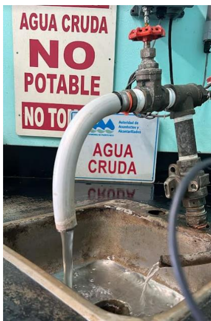
Figura 5. Grifo de agua cruda de la planta de tratamiento donde se coleccionaron las muestras y controles de agua cruda. Foto tomada por Zullymar Vélez.
